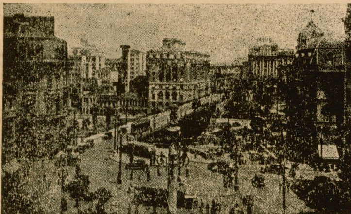
O Viaducto do Chá
