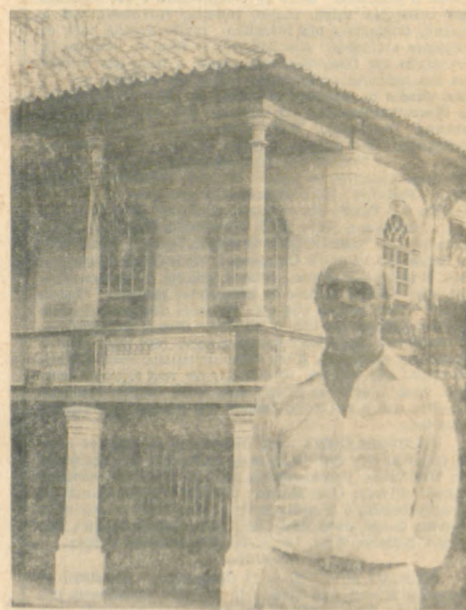
Olavo Sacchi restaurou inteiramente a construção da casa grande.
