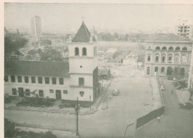
Obras em execução do plano do Pátio. Panorama que será visto do futuro belvedere. Lindeira à torre vê-se a área onde será construída a Igreja do Pátio do Colégio, vendo-se ao lado nos fundos o prédio da antiga Segurança Pública em fase de demolição.
