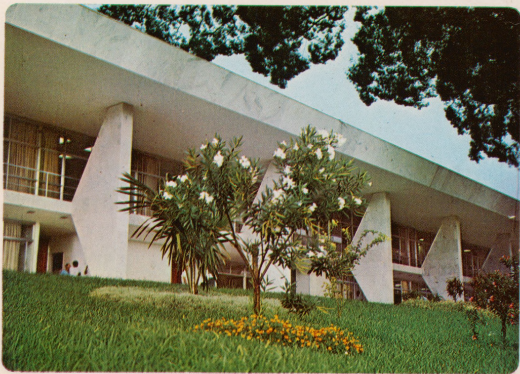
PAÇO MUNICIPAL — Palácio dos Jequitibás colosso branco de concreto e ferro, coberto de mármore e envolvido por alumínio e vidro. A área edificada é de 29.000 m 2 , com 17 pavimentos, de cujo cimo se descortina Campinas.
