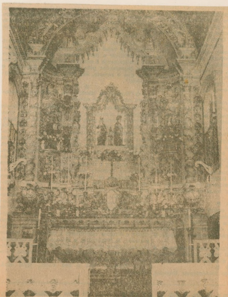
O altar-mor da igreja de N. S. do Deserto, contíguo ao mosteiro de São Bento, notando-se os estragos ocasionados pela ação do cupim
