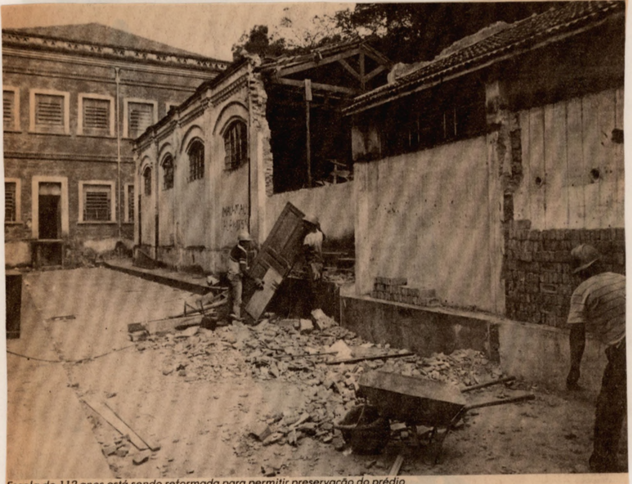
Escola de 112 anos está sendo reformada para permitir preservação do prédio
