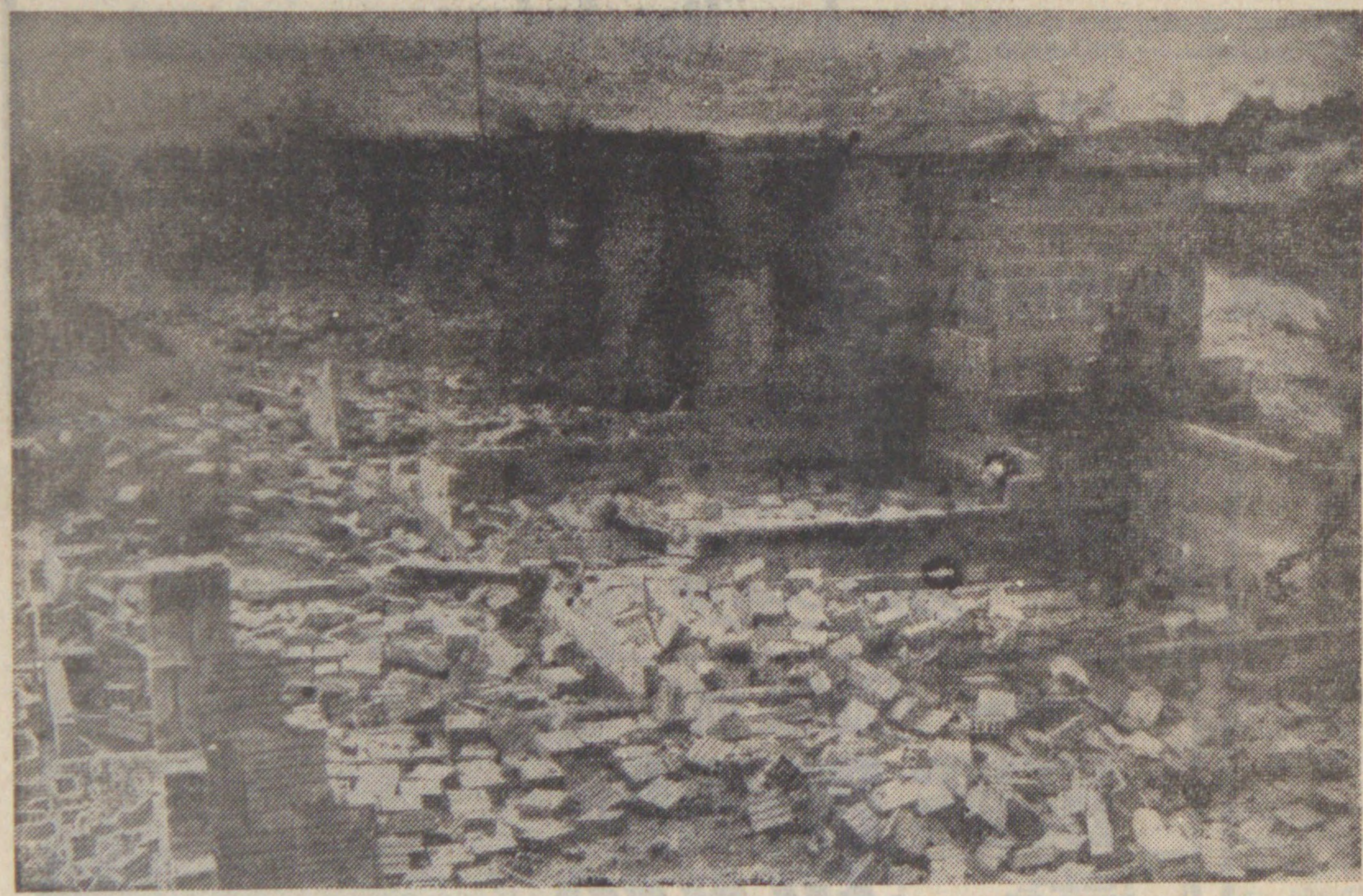
Chuvas fortes e construção precária. Várias casas em construção ruíram na tarde de ontem.
