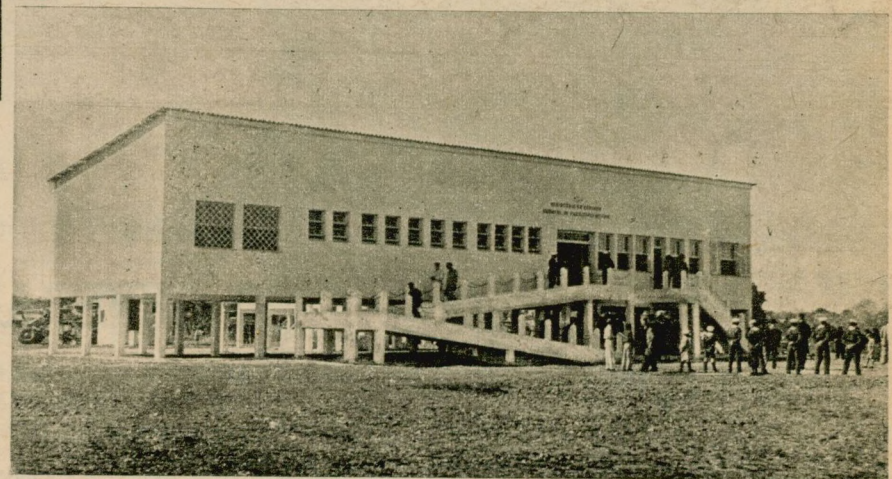
Atuais instalações do Pôsto de fronteira na confluência entre o Brasil, Argentina e Uruguai, em Barra do Quaraí. Como se vê, a Marinha está em guarda.
