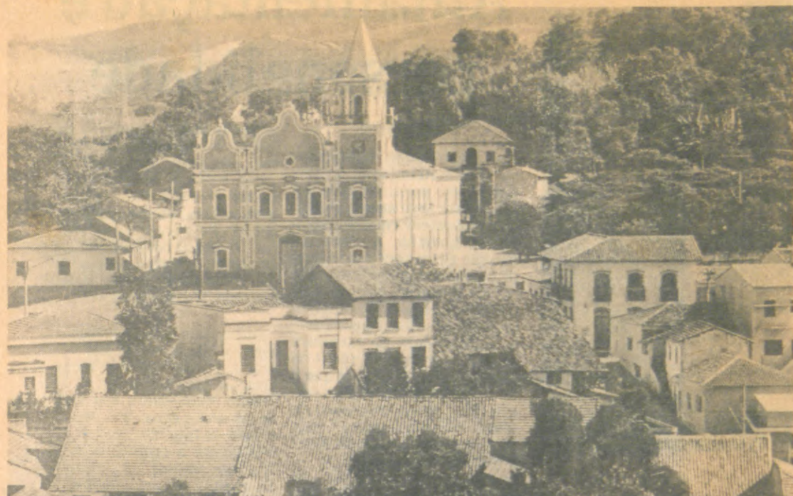
Santana do Parnaíba será declarada cidade histórica e seu núcleo central preservado pelo Condephaat. Um dos imóveis tombados, à praça da Matriz n.º 19, foi recentemente destelhado pelo proprietário a pretexto de reforma. Nada foi feito e a abertura continua, permitindo a entrada das chuvas, ameaçando ruir a casa, um raro exemplar de construção urbana paulista do século 18. O Condephaat vai denunciar o proprietário.
